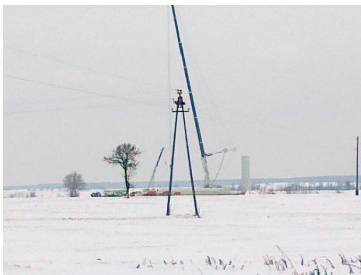
Budowa farmy wiatrowej Pawłowo-Gołańcz
